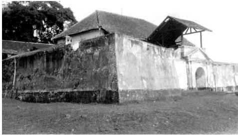
Gambar 178. Kondisi Benteng Williem II Tahun 1930
